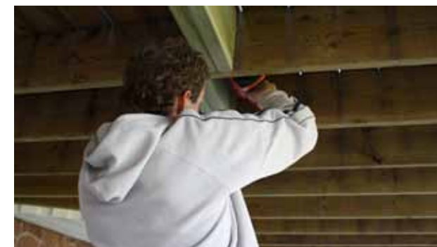
Är det riktigt trångt är det bekvämt att ha spikpistolen till hands. Den kräver dock ett utrymme på cirka 40 cm.
